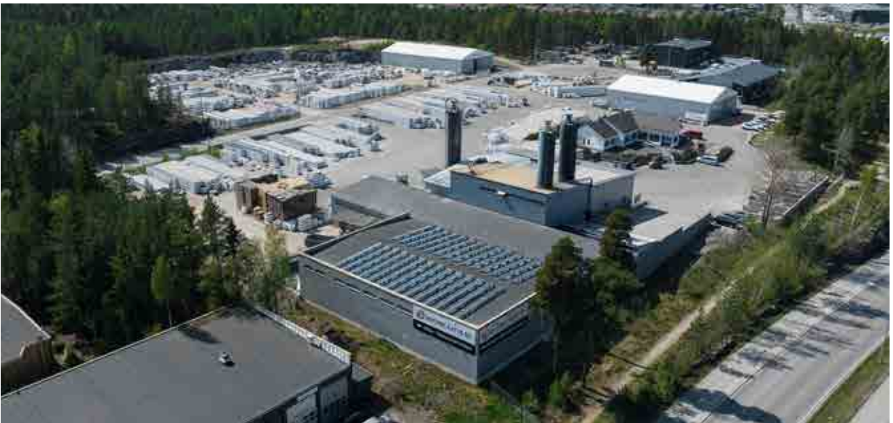
Betonilaatta Oy:n tehdas, toimisto ja pihakivimyymälä Sorvarinkadulla Turussa.
